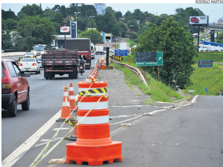
Obras iniciaram faz quase dois meses. Bloqueio inicia hoje a partir das 7h30min
