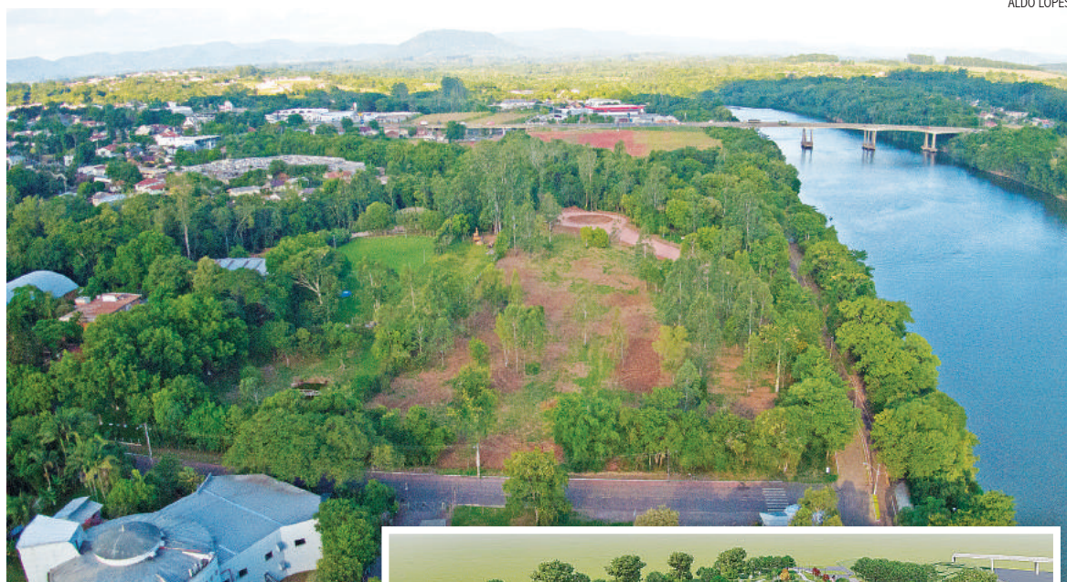
Obras movimentam uma área antes ociosa, às margens do rio Taquari
