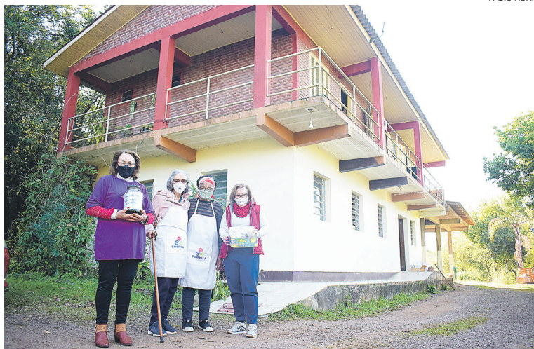
Representantes do Cohvisa relatam que prédio estava abandonado antes da ocupação pela entidade
