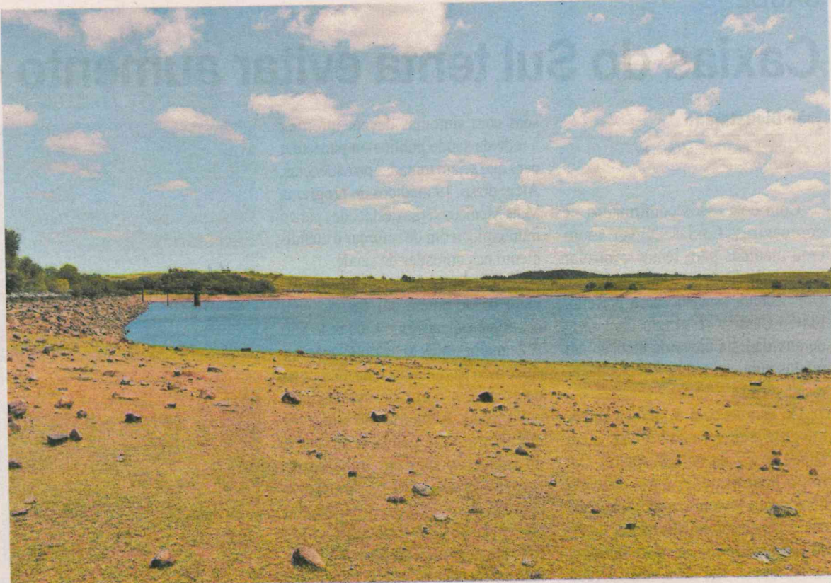
Barragem de Sanga Rasa, um dos locais de captação da cidade, está com cinco metros abaixo do normal
