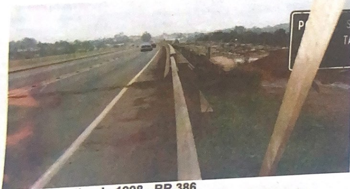
22 de julho de 1998 - BR 386 Antiga ponte sobre o rio Taquari sendo demolida
