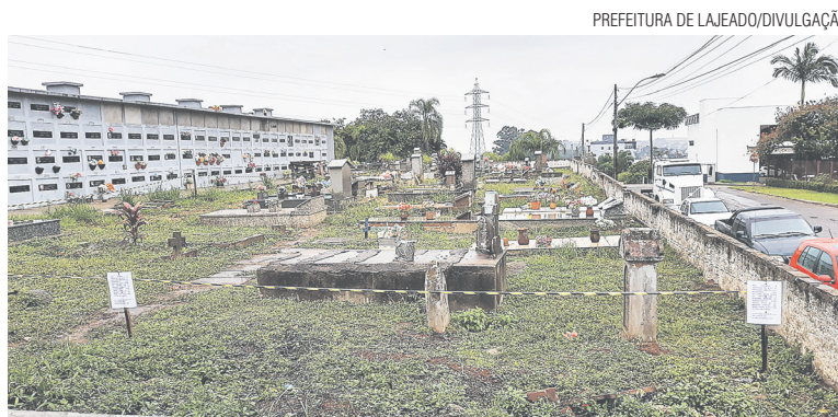
Obra será realizada no cemitério municipal do Bairro Florestal
