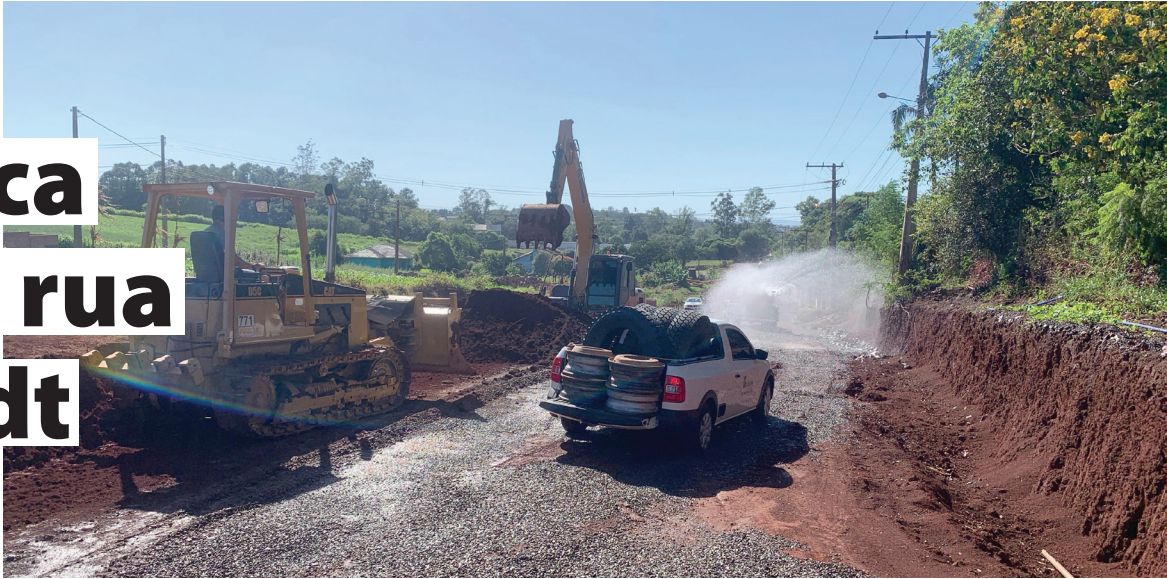
Parceria entre os proprietários das casas e a administração municipal permite a solução de parte do trecho
