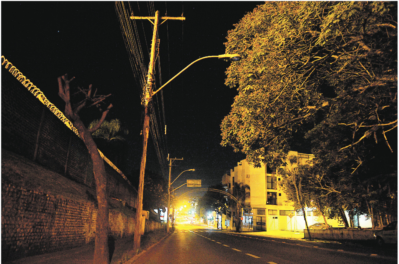
LAJEADO: sequência de postes sem luz em frente ao Presídio Estadual traz preocupação a quem passa pela Avenida Benjamin Constant
