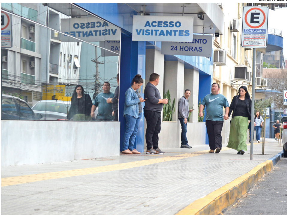
NO INÍCIO DE 2023, FOI CONCLUÍDA A REFORMA DAS CALÇADAS NO ENTORNO DO HBB
