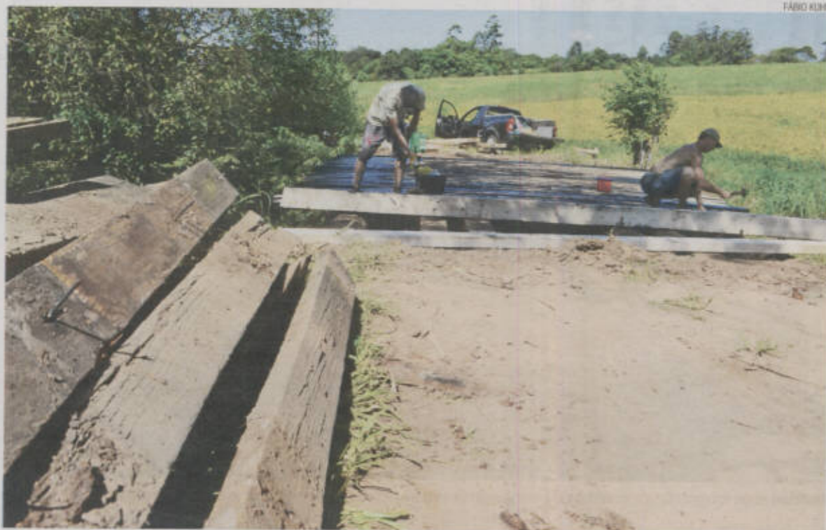
Ontem, a empresa contratada trabalhava na reforma de pontilhão da rua Arnoldo Antônio Scherer, no bairro Conventos
