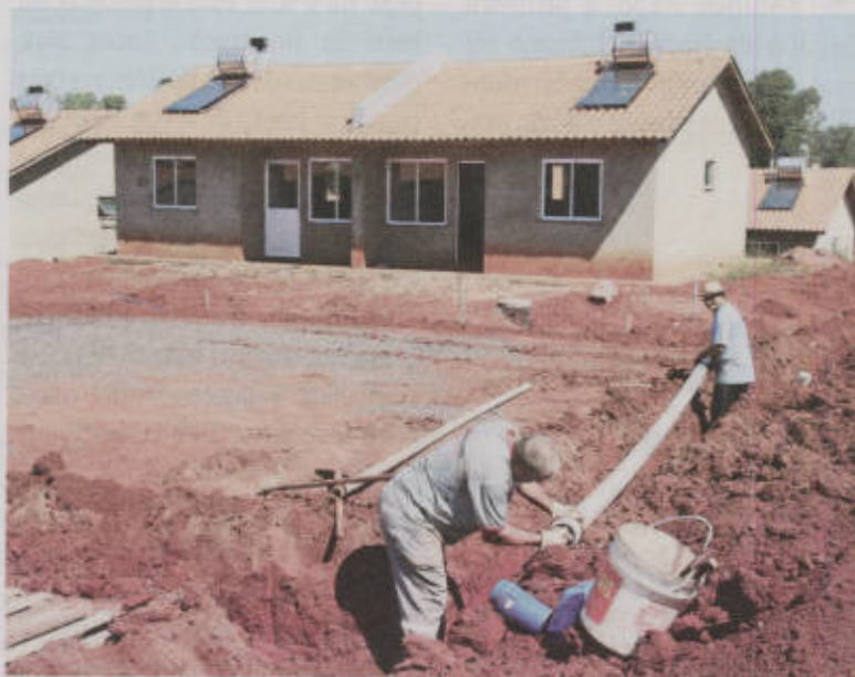
Acesso ao núcleo e ruas serão asfaltadas e receberão rede de esgoto
