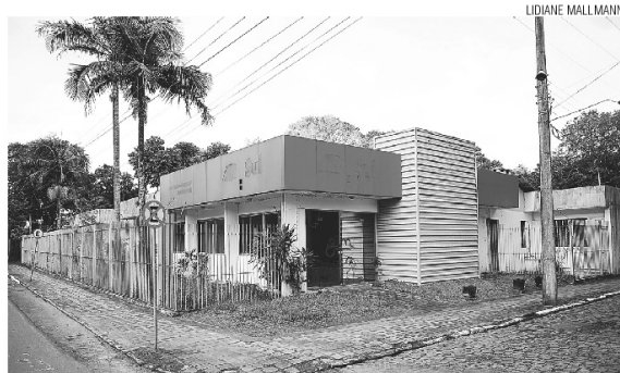
Prédio que está abandonado será demolido e nova sede da RGE será construída no local
