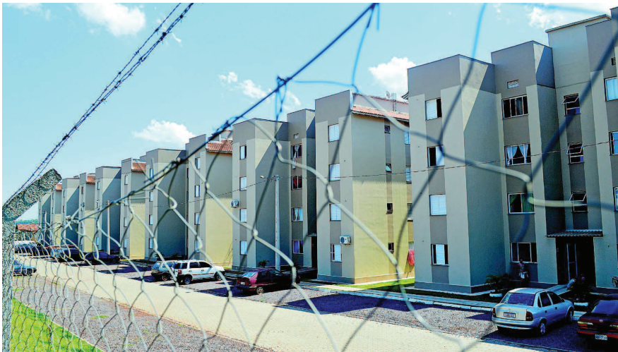
Condomínios foram construídos em área de vulnerabilidade social. Estima-se que 1,5 mil pessoas residam no local
