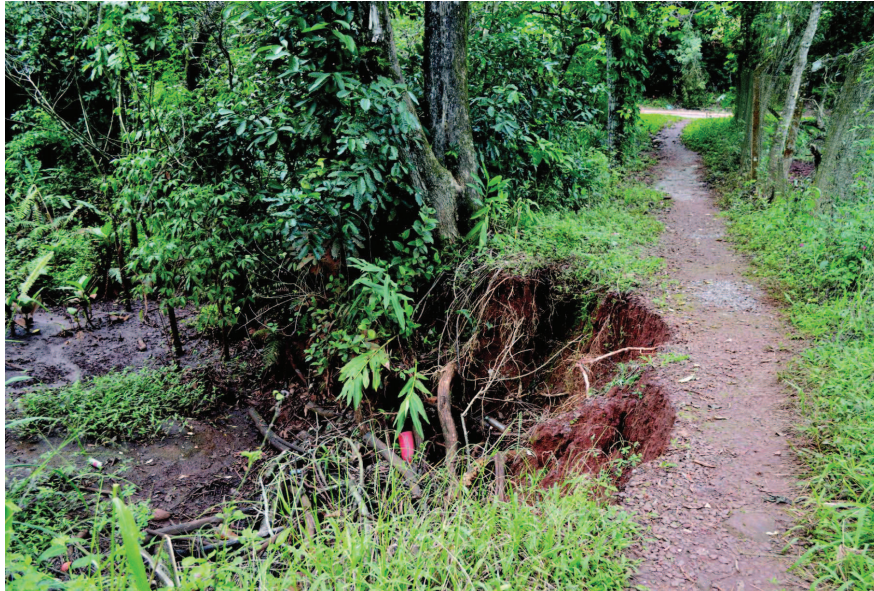
Há cerca de dois meses, travessia ficou ainda mais perigosa após desmoronamento causado pelas chuvas
