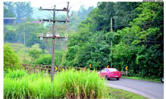
Remoção do poste iniciou na sexta-feira. Local será interrompido no domingo
