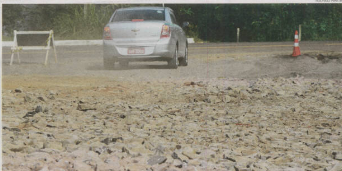
Conforme a fiscalização das obras do PAC, cerca de 60% dos serviços estão concluídos. Verba da CEF segue bloqueada
