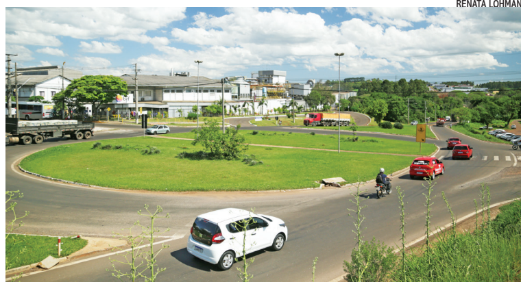
Com a construção de vias marginais e passagem em desnível
