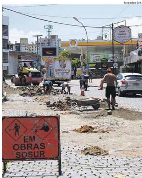
RESTAURAÇÃO: servidores da Sosur começaram os trabalhos na segunda-feira, próximo ao cemitério do Centro
