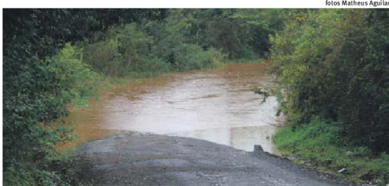
INTERDITADO: trecho da Rua Albino Francisco Horn, na ponte sobre o Arroio Estrela, na tarde de ontem
