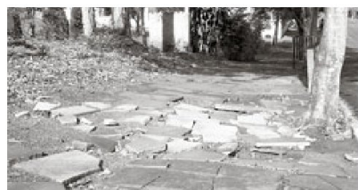
SEM CONDIÇÕES: lajes soltas dificultam a passagem em um ponto do Bairro Alto do Parque
