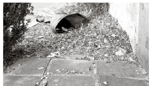
SEM SAÍDA: trecho sem calçada interrompe a passagem do pedestre no Bairro Moinhos
