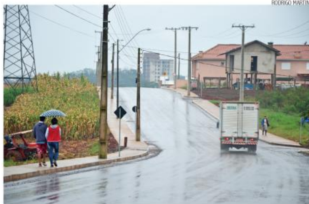
Obras estão 80% concluídas. A rua Arnoldo Uhry carece de sinalização viária
