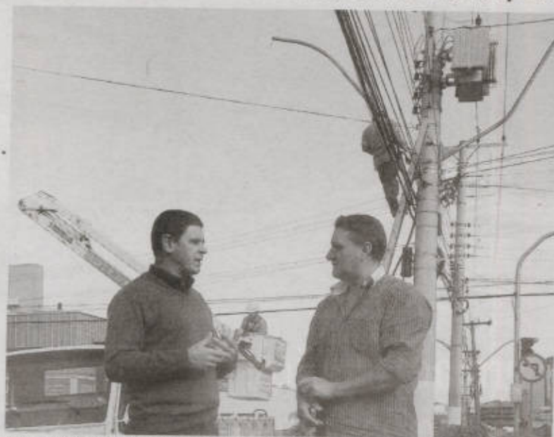
Heisser (e) e Cerutti acompanharam a instalação das lâmpadas de LED
