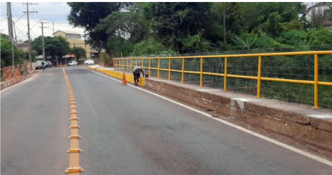
Reforma na Ponte do Saraquá está entre as obras investigadas. Além da apuração interna, CPI tramita na câmara
