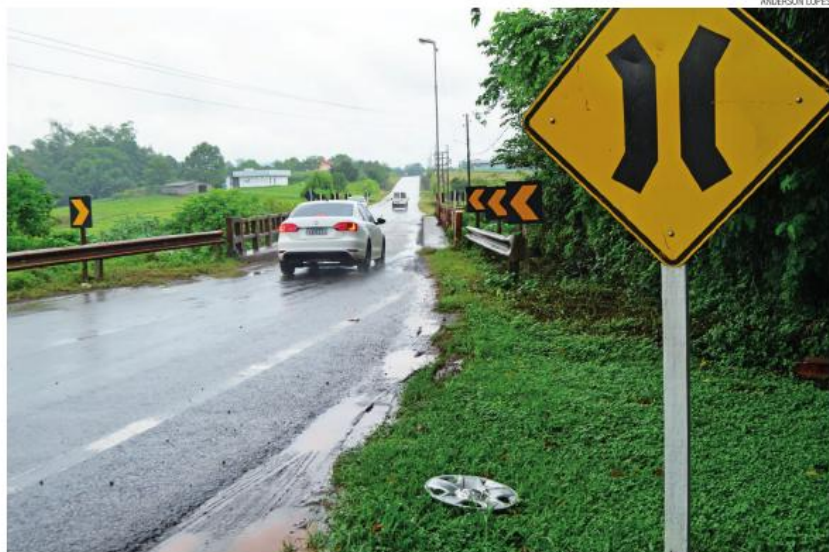
A ponte com uma só via na ERS-413 causa riscos a quem trafega entre os bairros de Lajeado e Santa Clara do Sul
