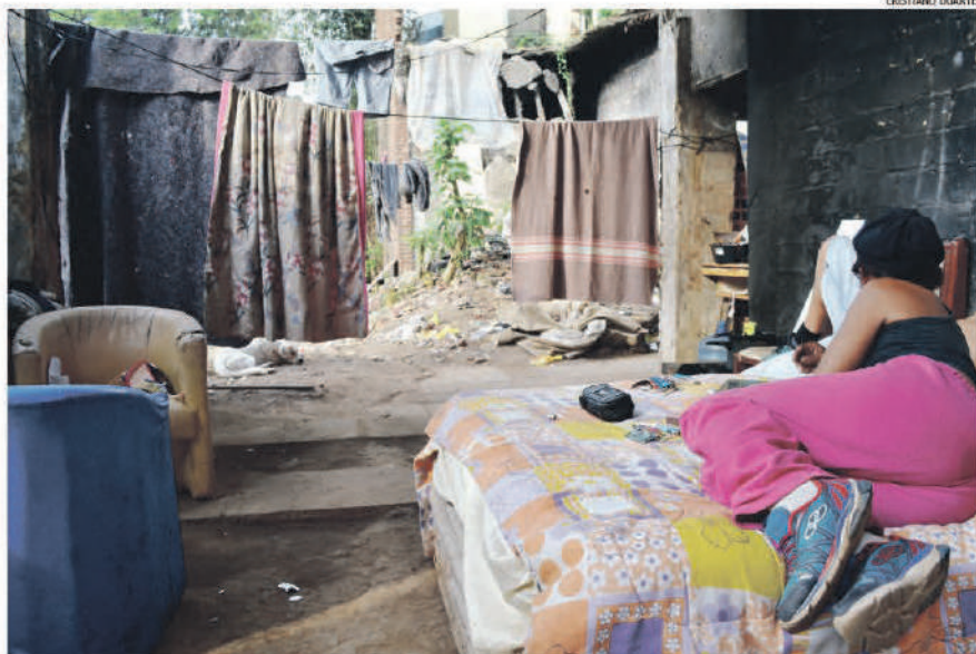
Cerca de 10 pessoas vivem na Casa do Bruno Born, no centro, sob o risco de desabamento iminente do local
