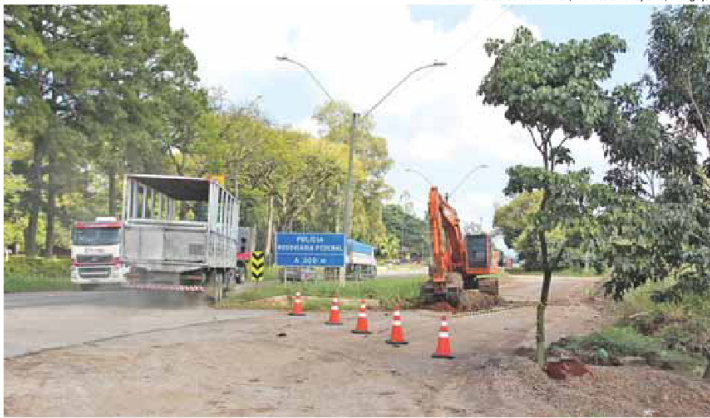
MELHORIA: obra foi iniciada com escavação do trecho que será posteriormente asfaltado
