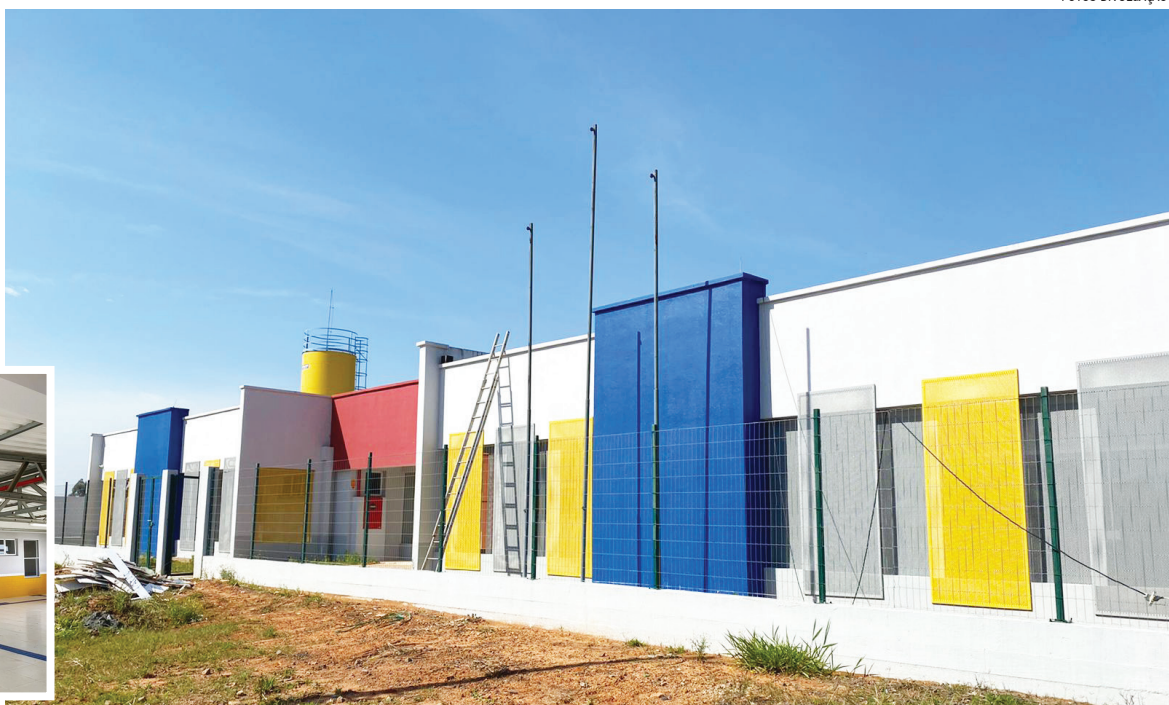
Construção da escola de educação infantil iniciou em junho de 2016, com um investimento de R$ 1,37 milhão
