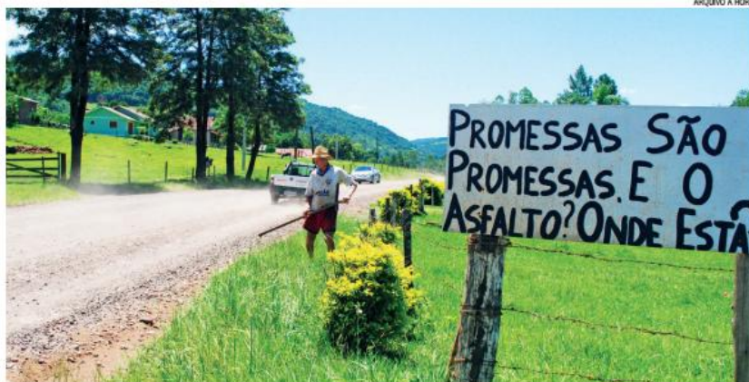
Pavimentação começou durante o governo Brito. Em 2013, moradores fizeram protestos pedindo o término da obra
