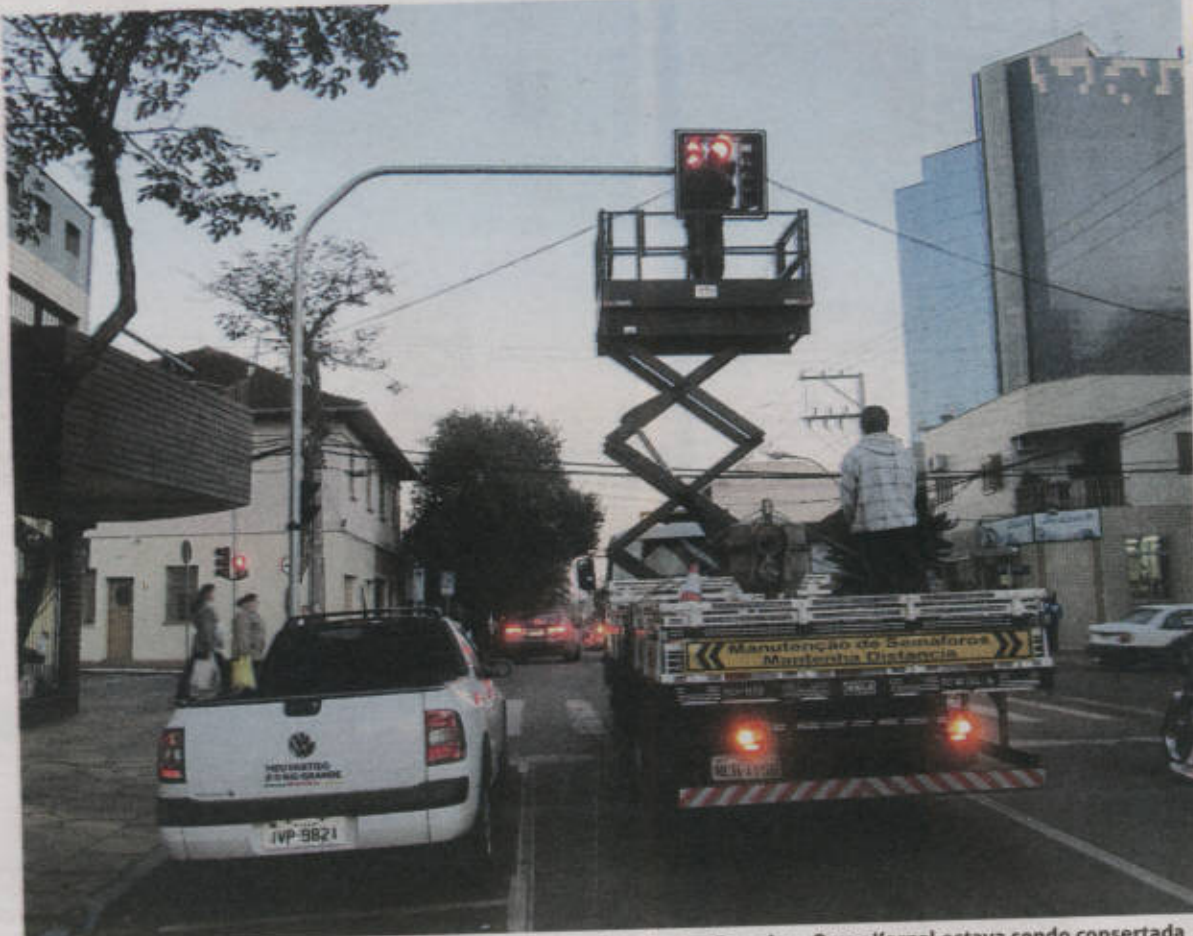
Por volta das 18h30min, a sinaleira que fica próximo à esquina da Rua Francisco Oscar Karnal estava sendo consertada
