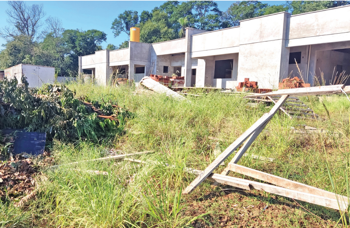
No local não há trabalhadores. Obra deve ser retomada na próxima semana
