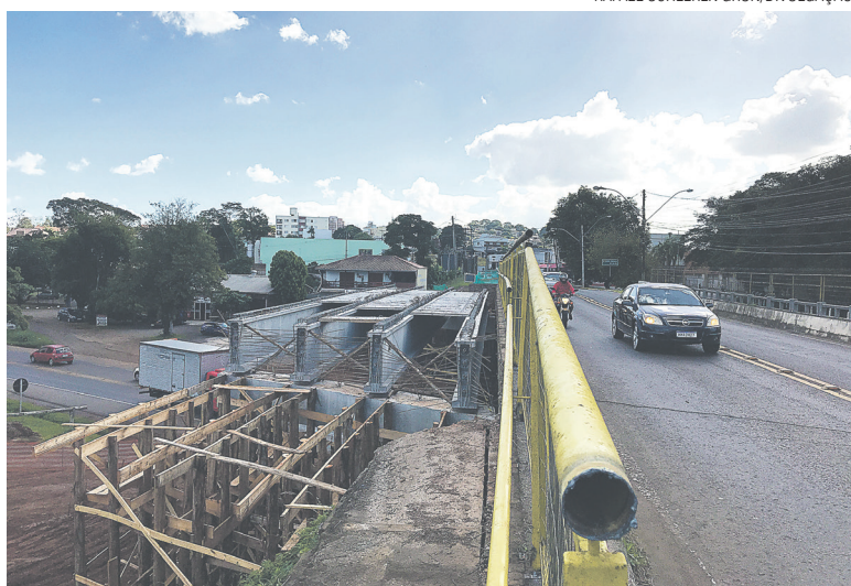
No fim de semana foram instaladas as pré-lajes sobre as vigas
