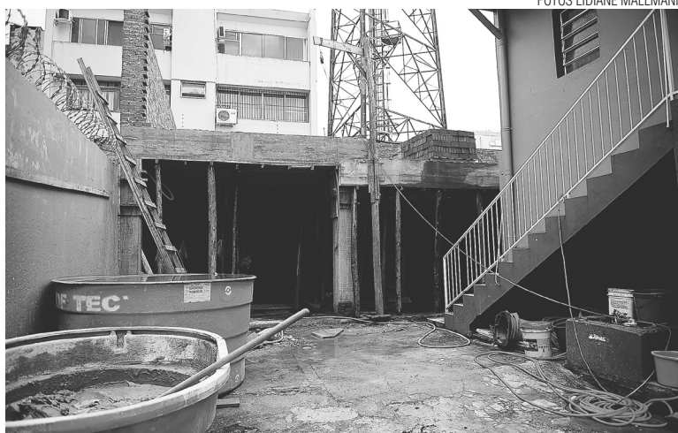
Obra está sendo realizada no terreno junto ao 22º Batalhão de Polícia Militar
