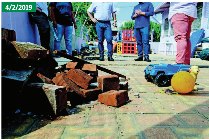
Faz 10 dias, pátio da creche onde crianças usam para brincar servia de depósito da obra na EMEI
