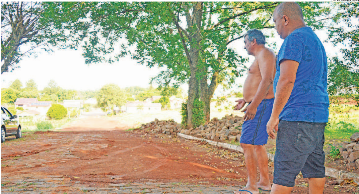
Maia e Oliveira mostram trecho onde foi retirado calçamento. Ontem à tarde, uma equipe terceirizada retomou trabalhos e iniciou recolocação das pedras
