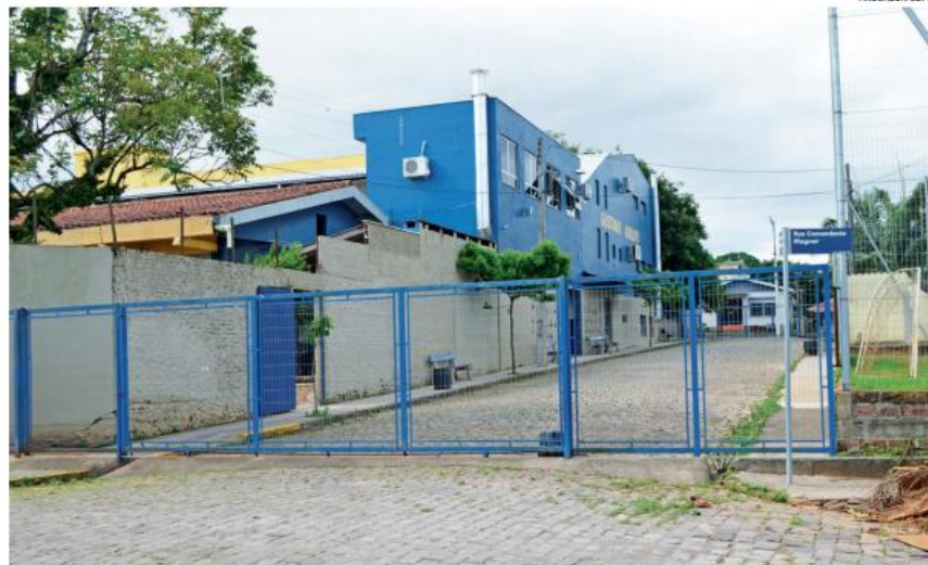
Rua no São Cristóvão permanece fechada faz quase quatro anos. Situação confronta moradores e direção do colégio
