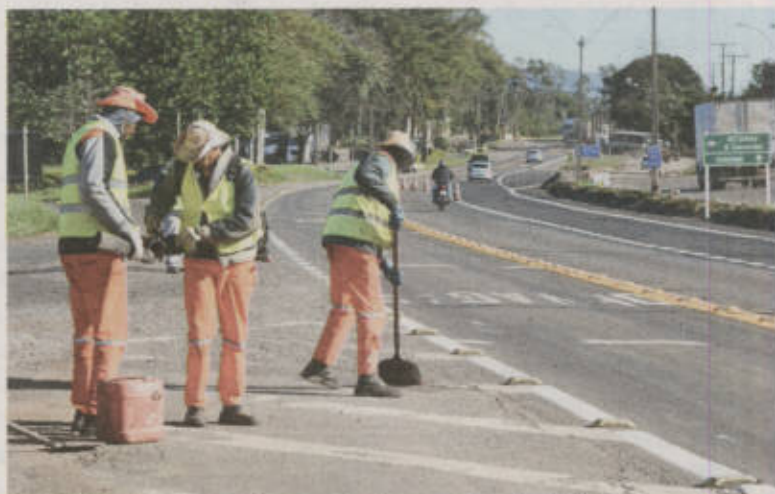
Servidores do Dnit instalaram os tachões na pista da BR-386 ontem
