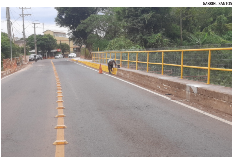
Reforma na Ponte do Saraquá está entre as obras investigadas
