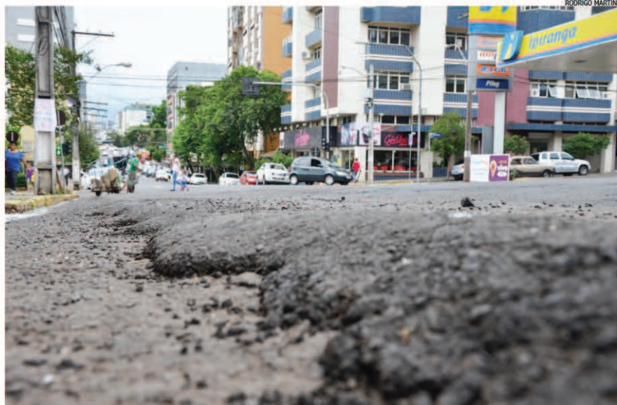
Previsão é começar a obra já no próximo mês. Prazo estipulado em contrato prevê 30 dias para finalizar
