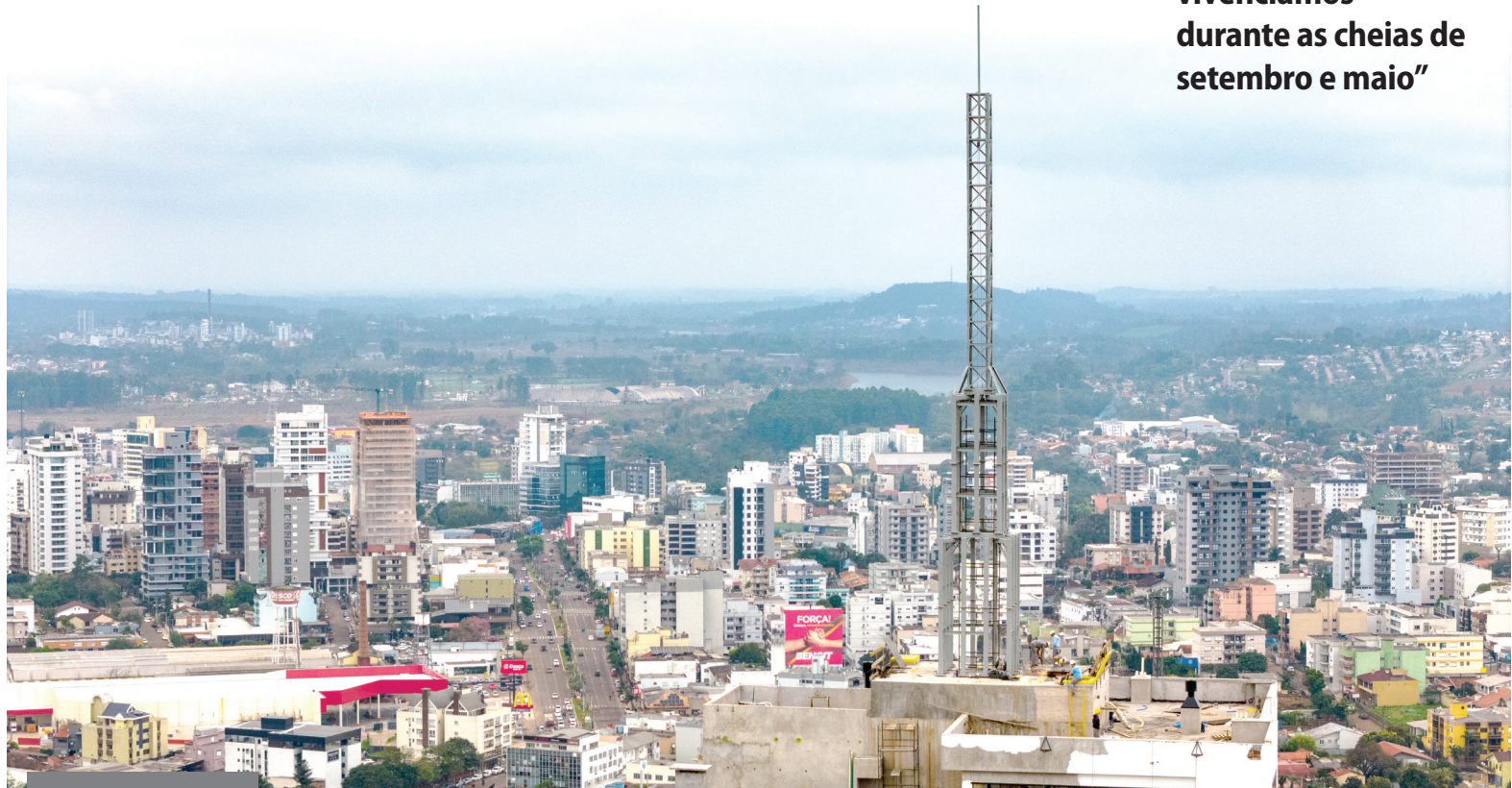
Em Lajeado, antena é instalada no prédio São Cristóvão, da Lyall
