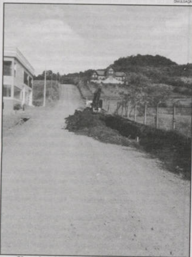
Obras de asfaltamento começaram nesta semana
