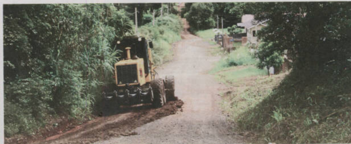
No bairro São Bento, equipe de servidores da Secretaria de Obras atuou na recuperação da rua João Saffran
