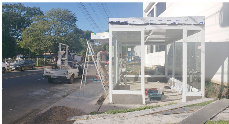
Nova estrutura contará com ar-condicionado, bebedouros e tomadas
