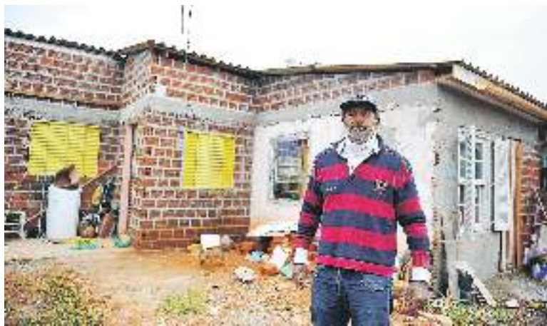
Servente de pedreiro, Tomás Gaspar de Moraes (52) construiu sua própria casa na Rua São Leopoldo
