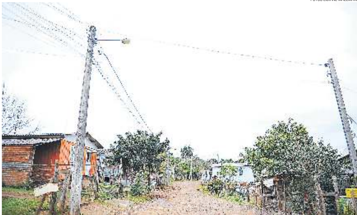
Cerca de 400 moradias estão em área irregular no Bairro Santo Antônio
