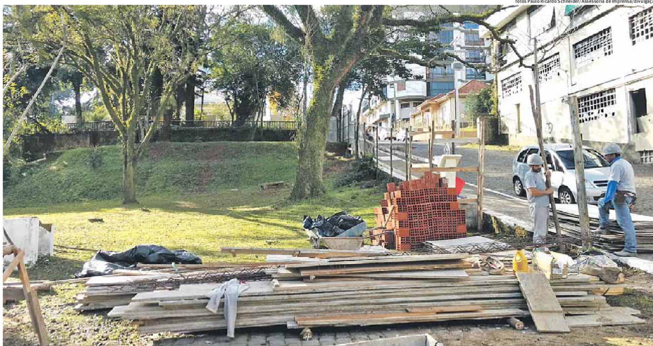
TAPUMES: empresa inicia cercamento de área para trabalhos de revitalização de importante espaço público de Estrela
