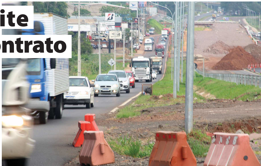
Governo de Lajeado cobra mais agilidade para conclusão da obra e também melhoria nos acessos e retornos
