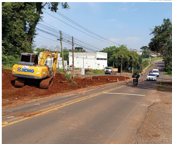
Intervenção prevê a implantação de canteiro central e melhorias na circulação e segurança do trecho
