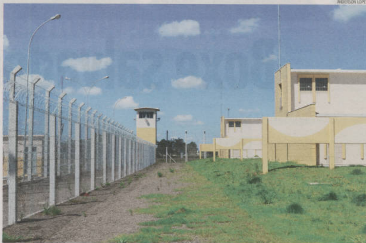
Penitenciária de Venâncio Aires abrigará 170 presos do regime fechado de Lajeado. Transferências começaram ontem
