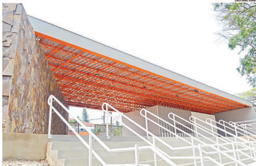
Orçada em R$ 295 mil, obra do pórtico começou em julho. Projeto arquitetônico visa representar história de Lajeado
