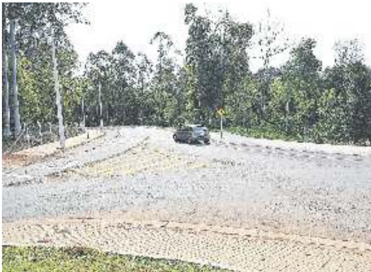
Acesso ao novo parque lajeadense, na margem do Rio Taquari
