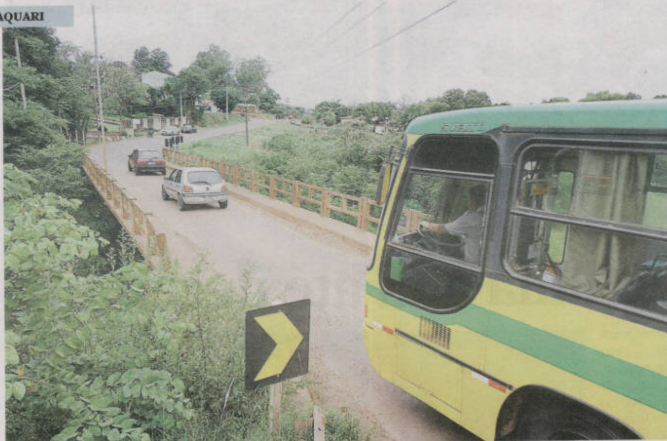
Nova ponte ficará seis metros à esquerda da atual, no sentido Lajeado/Santa Clara do Sul
