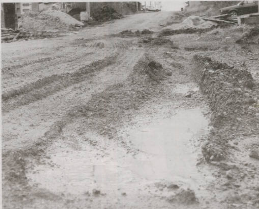
Moradores da Rua Ângelo Pulita, no Bairro Conventos, sofrem com a presença do barro
