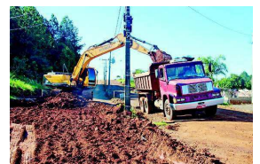
Rua passa por terraplanagem para receber a pavimentação
