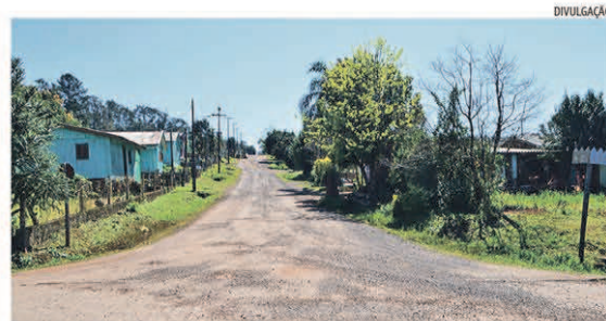
Rua João Paulo II e trecho da Lovane Hauschild serão pavimentadas
